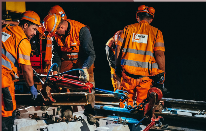
Zwei neue Schienenabschnitte werden miteinander verbunden.
