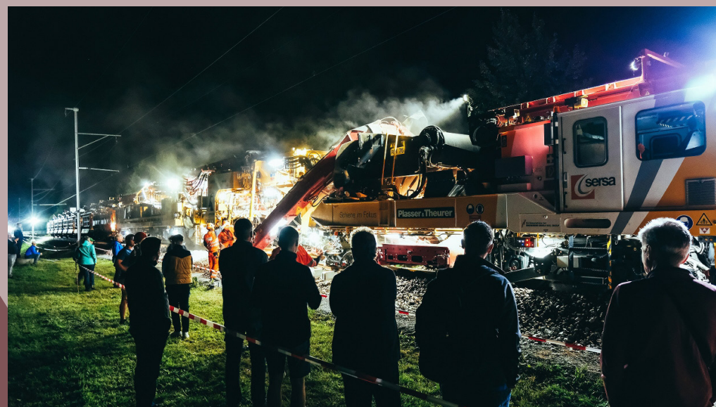
Die Schotterreinigungs-Maschine RM 76 im Einsatz.
