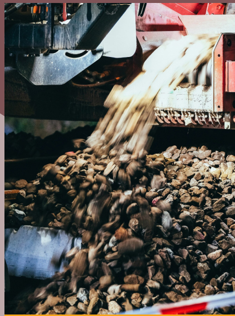
Die Schottersteine fliessen übers Laufband zurück zum Geleis.
