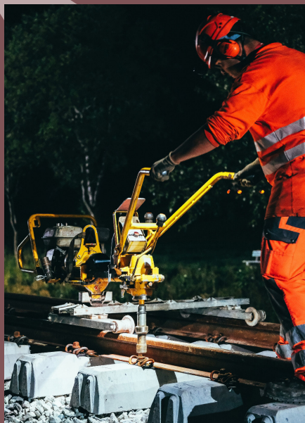
Die neuen Schienen werden an den ebenso neuen Schwellen festgeschraubt.
